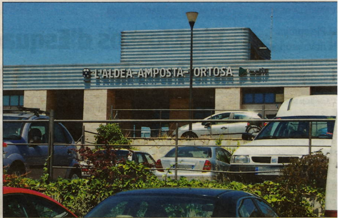
Vista actual de l'exterior de l'estació de ferrocarril de l'Aldea-Amposta-Tortosa. /L'EBRE
