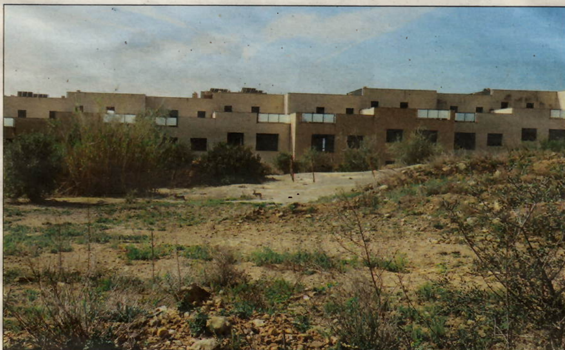
Panoràmica de la urbanització inacabada de la promotora Martinsa-Fadesa, a la finca de la Palma. /ANDREA CAPILLA
