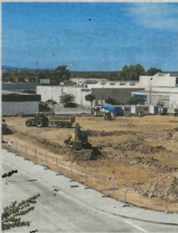
Treballs amb excavadores, ahir. FOTO: J. REVILLAS
