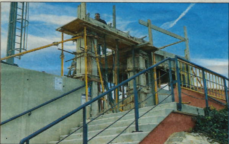
Obres de millora a les instal·lacions esportives de l'Ametlla de Mar. /CEDIDA
