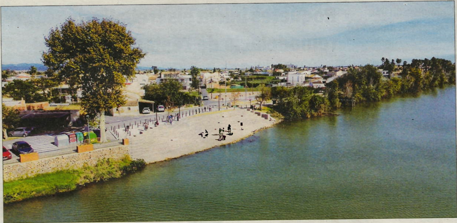
Vista de dron del nou mirador del Balcó dels Mirons, construït amb una estructura esglaonada a la vora del riu Ebre i amb vistes a l'illa de Gràcia. /CEDIDA
