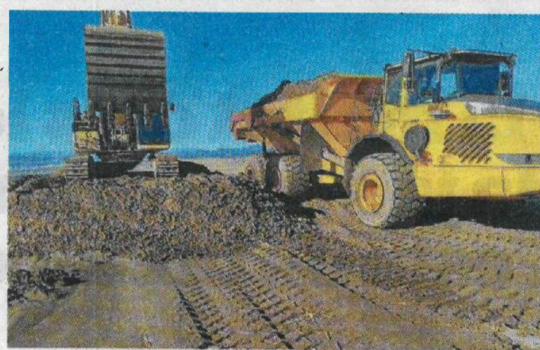
Moviments d'arenas en marxa per reforçar les parts més afeblides de l'istme. FOTO: SUBDELEGACIÓ DEL GOVERN A TARRAGONA
