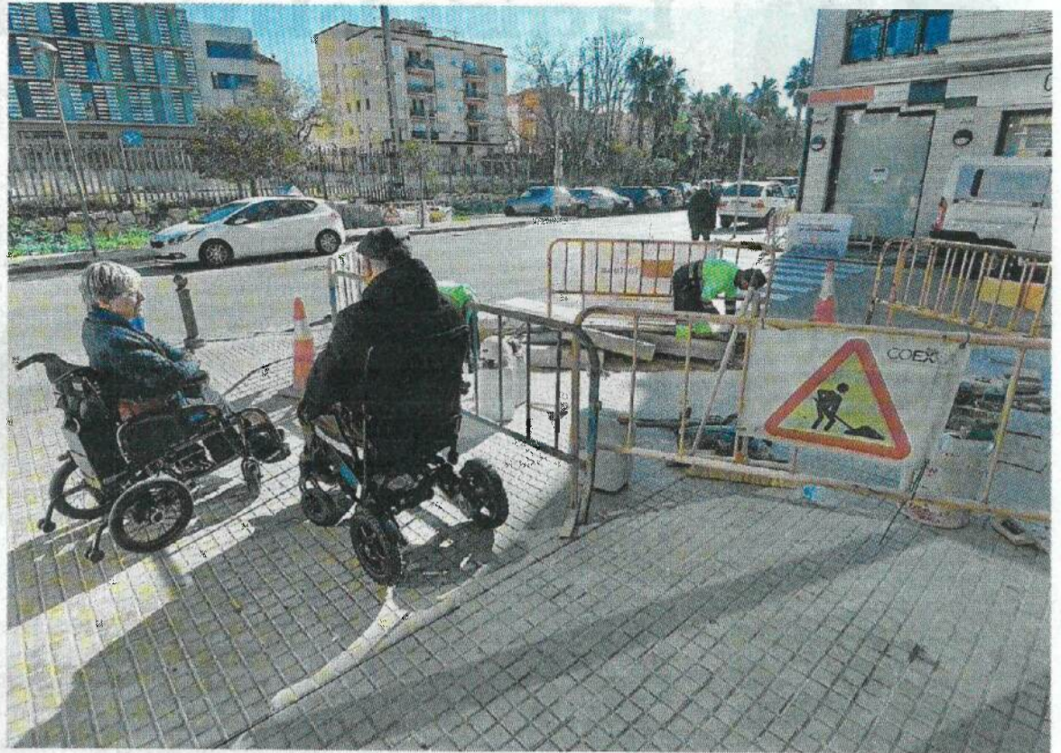
Membres de l'entitat ASSIDE observant les obres en marxa.
