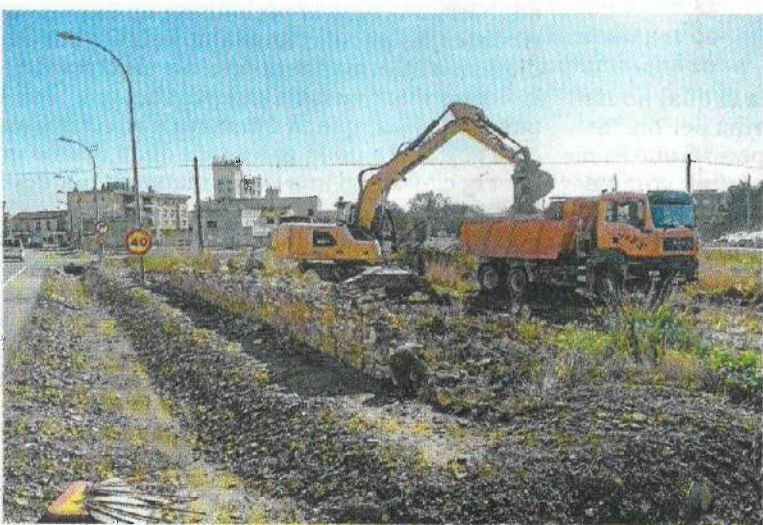
Les obres en execució. FOTO: JOAN REVILLAS
