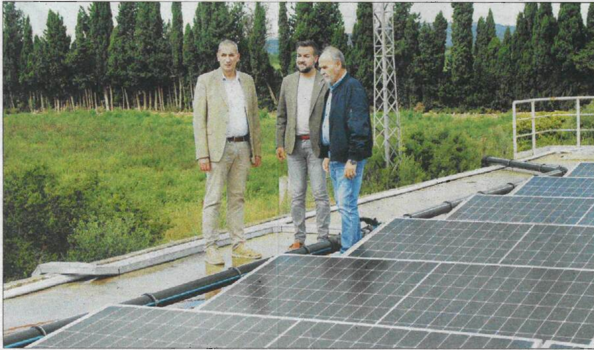
La inversió en la reactivació dels pous s'ha complementat amb la instal·lació de 233 plaques fotovoltaïques. /CEDIDA
