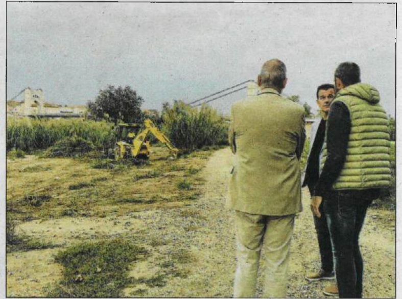
Antoni Gilabert, Xavier Royo i Ivan Garcia, durant la visita d'obres. /CEDIDA
