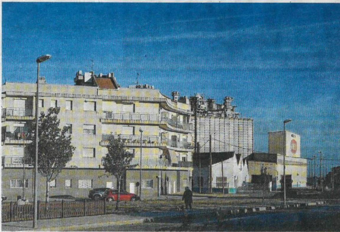
Les instal·lacions de la Càmera Arrosera, a la ciutat d'Amposta. FOTO: JOAN REVILLAS
