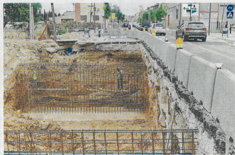
Estat actual de les obres al pont del barranc dels Pixadors, al nucli urbà de l'Aldea. FOTO: JOAN REVILLAS
