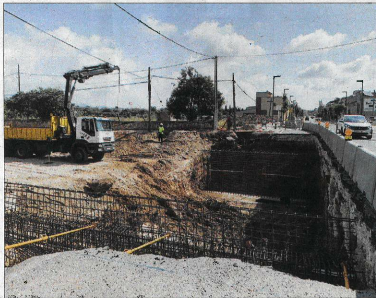
Imatge d'este dimarts, de l'estat de les obres al Barranc dels Pixadors, al seu pas pel pont de l'avinguda Catalunya -antiga N-340-. / A.C.A.
