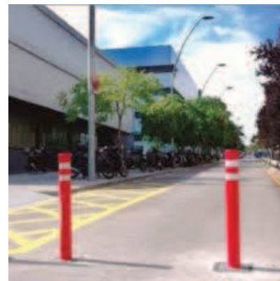
Figura 3. Fita de protecció mecànica
